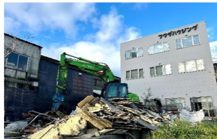
▲解体中の関新モデルハウス
