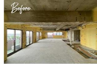
【写真:マンション内部の壁などをすべて撤去し、スケルトンにした状態】
